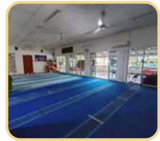
Baik Pulih & Memasang Siling Surau At-Taqwa Kepong Selangor
